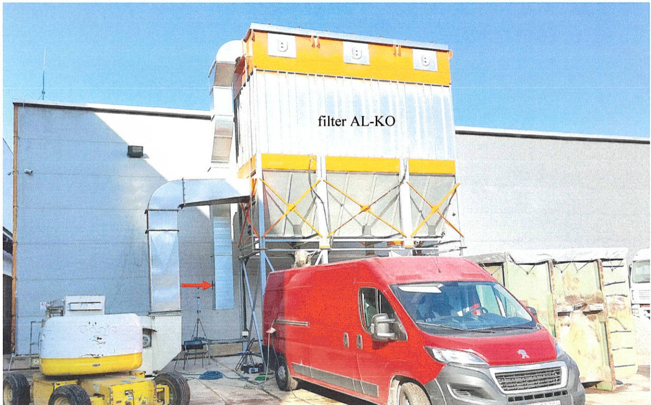
Obrázok č. P.3.1 Zobrazenie odprašovacieho zariadenia s vyznačením meracieho miesta
